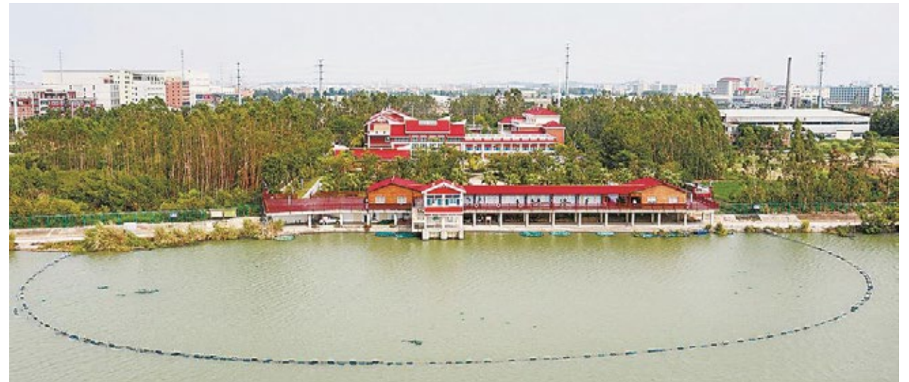
航拍下的晋江龙湖水库泵站
