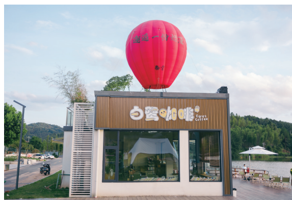
泰寧縣杉城鎮南會村水岸咖啡館
